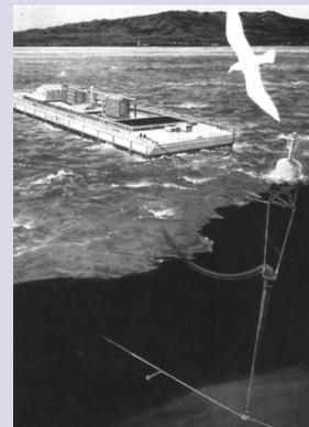
T (cean Thermal nergy onversion) adalah sebuah pembangkit tenaga listrik mini. Mesin ini bekerja berdasarkan perbedaan suhu antara permukaan laut yang hangat dan kedalaman laut yang dingin. Pusat pembangkit listrik ini bebas polusi.
